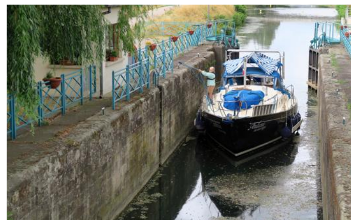
Une des trois écluses du canal de Colmar.
