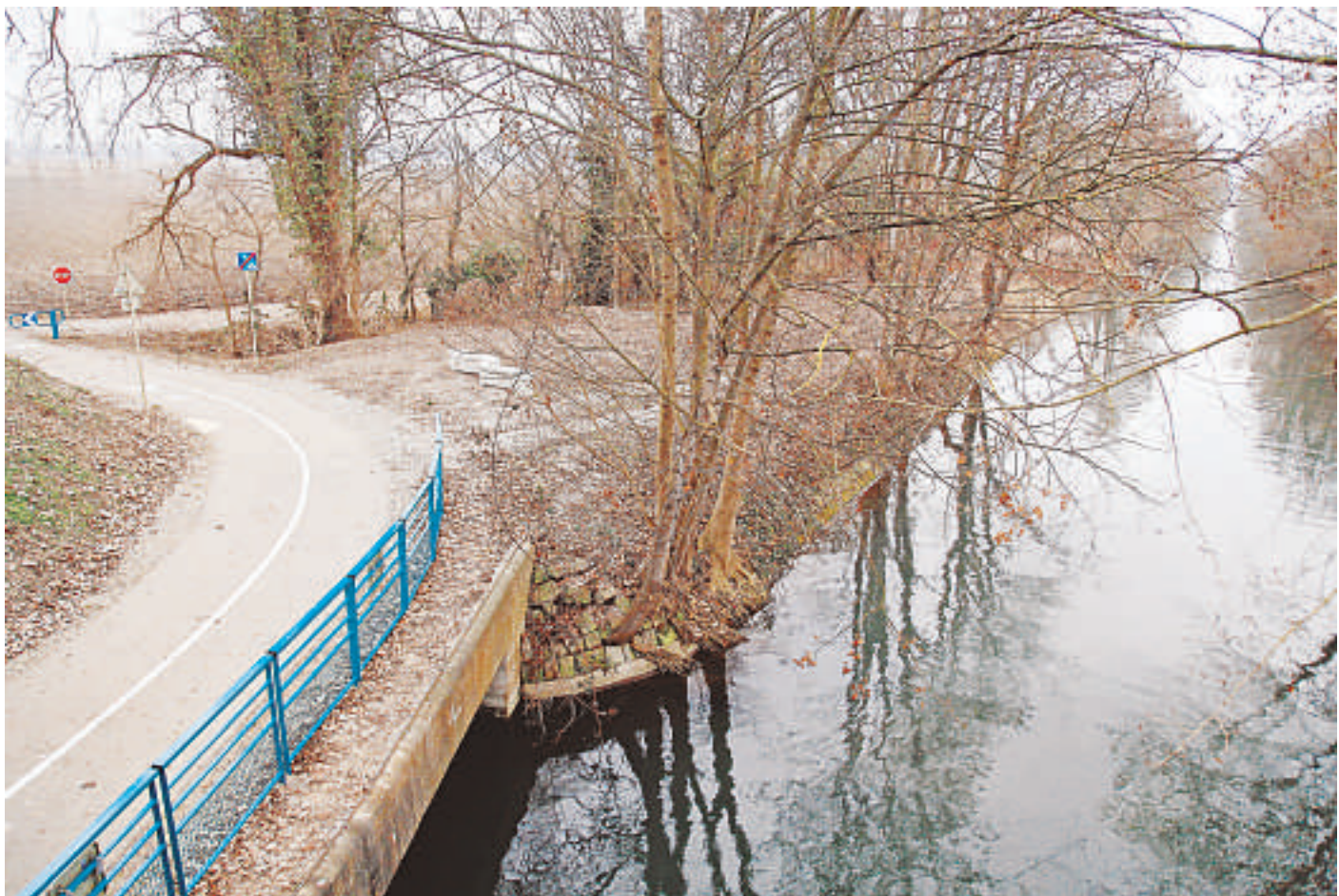
Le canal du Rhône au Rhin à Artzenheim. Faut-il prolonger son ouverture jusqu'à Neuf-Brisach ? (Photo DNA-Laurent Habersetzer)
